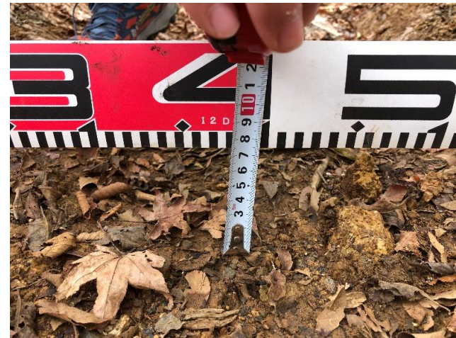
④ モニタリングポイント(洗掘高)
