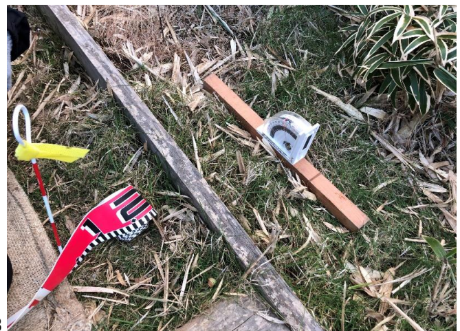
⑤ モニタリングポイント(傾斜角度)
