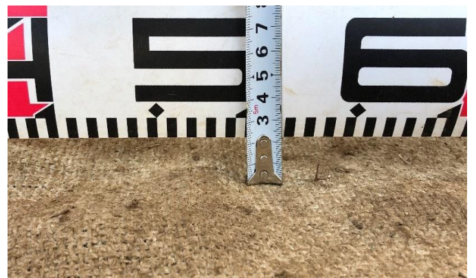
④ モニタリングポイント(洗掘高)
