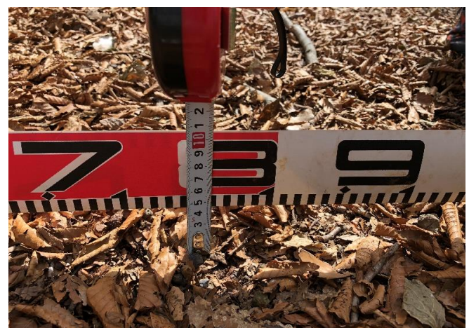
④ モニタリングポイント(洗掘高)
